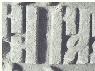
Рис.46. Обрастание закладных плит в Подземной палате колониями микроорганизмов. С поверхности плит отбирались пробы для определения численности микроорганизмов биолюминесцентным методом.
