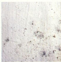
Рис. 24. Развитие грибов на стене вследствие конденсационного увлажнения в неотапливаемом памятнике
