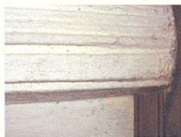
Рис. 24. Развитие грибов на стене вследствие конденсационного увлажнения в неотапливаемом памятнике
