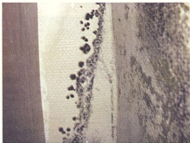
Рис. 22. Развитие грибов на стенах вследствие конденсационного увлажнения в холодное время года музейного зала, в котором параметры микроклимата поддерживаются с помощью централизованной системы кондиционирования
