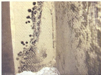
Рис. 22. Развитие грибов на стенах вследствие конденсационного увлажнения в холодное время года музейного зала, в котором параметры микроклимата поддерживаются с помощью централизованной системы кондиционирования
