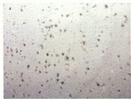
Рис. 24. Развитие грибов на стене вследствие конденсационного увлажнения в неотапливаемом памятнике
