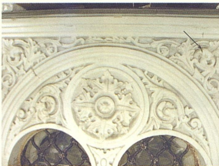
Рис. 37. Восточный фасад Оружейной палаты. Белокаменная резьба. Стрелкой показана зона деструкции камня.
